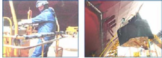
그림 11. 고소차 작업의 쿠션 및 바람막이 설치
